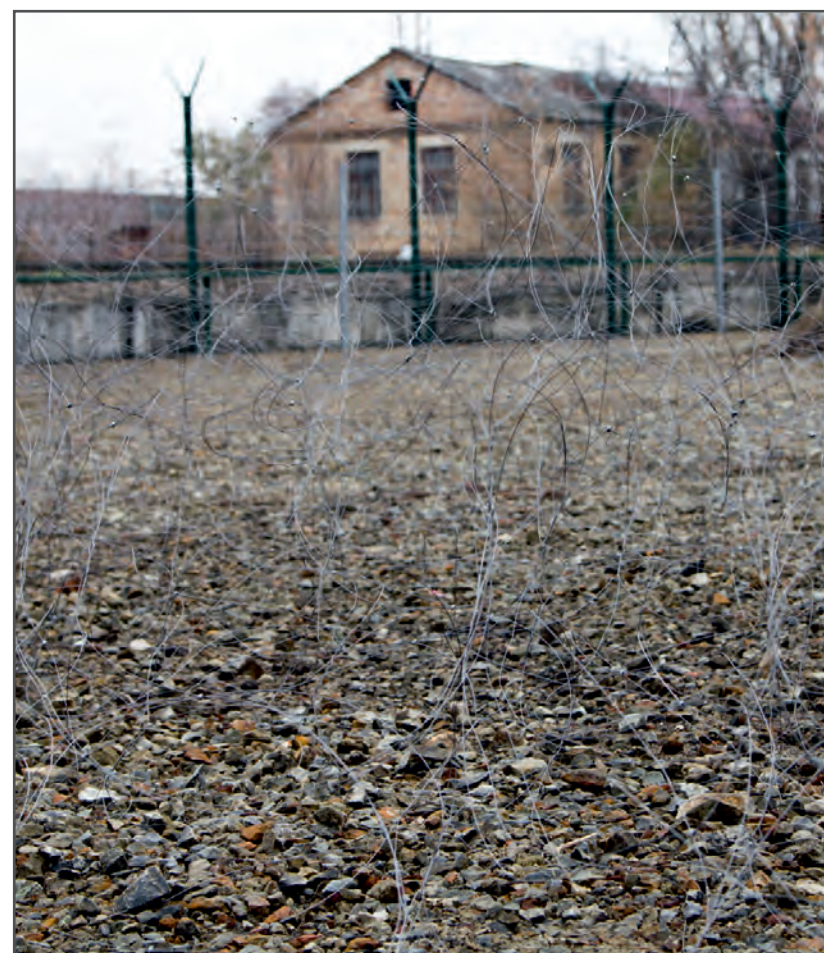
Типовое решение по установке МЗП на земле, в качестве полосы отчуждения
