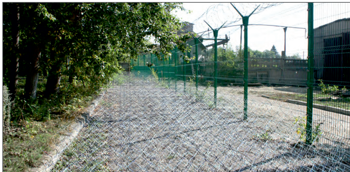
Типовое решение по установке МЗП на земле, в качестве полосы отчуждения
