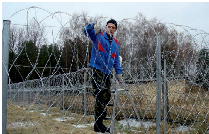
Пример установки заграждения ПКЗ
