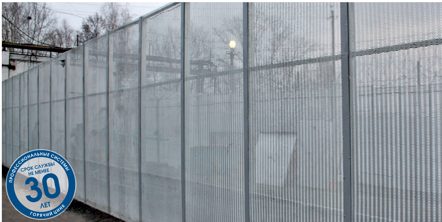
Полотно заграждения - просечно-вытяжной лист
