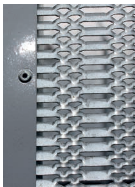
Полотно заграждения - просечно-вытяжной лист
